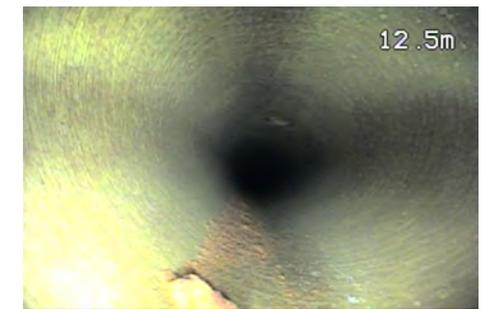
⑥穿孔部 穿孔部の管底部付近に錆の堆積を確認。
