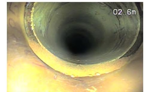
④堆積物 管底部に錆の堆積を確認。
