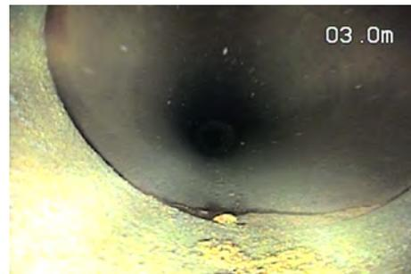
⑤浮遊物 接合部に錆の堆積を確認。常時、浮遊物を確認。
