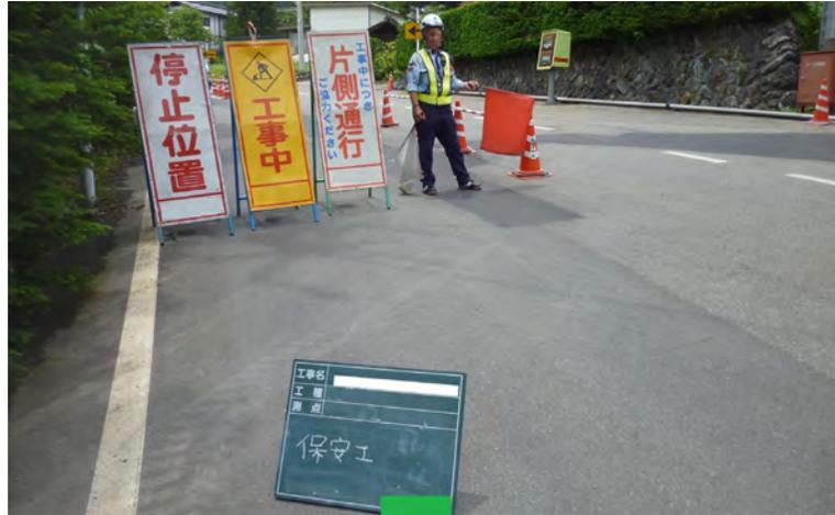
写真2-2-1 保安設備、誘導員配置状況
