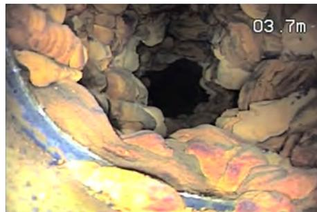
⑥異形管部 管内面が錆こぶで閉塞。
