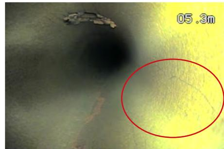
③内面防食状況 穿孔部に発錆を確認。シーラントの亀裂を確認。
