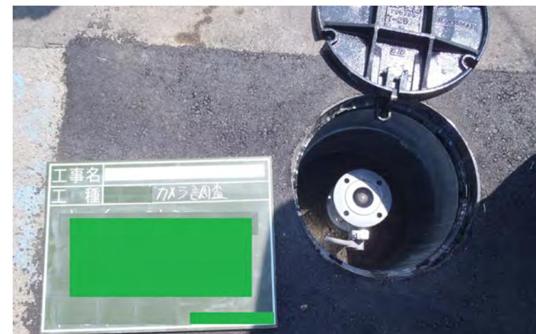
写真2-1-1 カメラ調査孔（ボール式補修弁）
